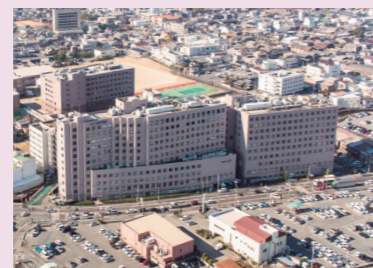
高木病院(福岡県大川市)
